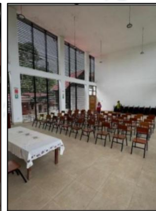
Imagen N° 98: Ambientes no presentan suministro eléctrico
