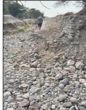
Imagen N° 60: Colapso parcial de muros del acueducto de Ocongalla
