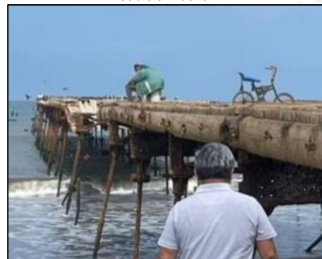
Imagen N° 77: Presencia de pescadores artesanales sobre el Muelle
