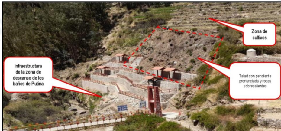
Imagen N° 102: Talud con pendiente pronunciada sin reforzamiento sobre la zona de descanso de los baños de Putina
