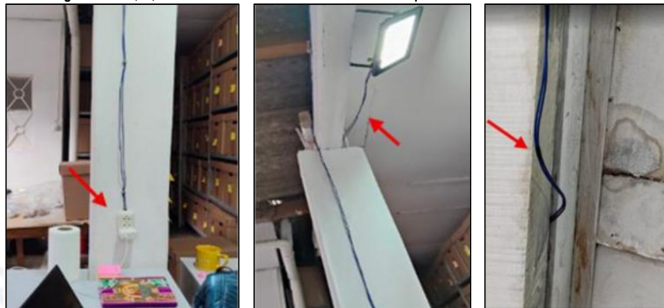
Imágenes N° 11,12,13 : Presencia de instalaciones eléctricas expuestas dentro del Gabinete del PRIAK
