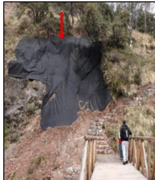
Imagen N° 87: Geomembrana sobre el talud, ubicada en tramo final del Camino Ritual Inka
