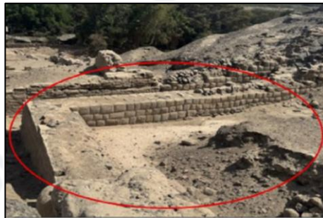
Imagen N° 55: Zona del complejo arqueológico con riesgo de empozamiento
