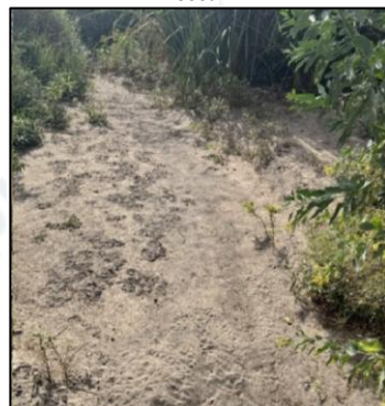
Imagen N° 61: Cocha al final del acueducto de Ocongalla completamente seca
