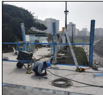
Imagen N° 116: Trabajos pendientes de concluir
