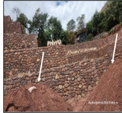
Imagen N° 90: Tierra zarandeada para la preparación de mortero sin protección adecuada
