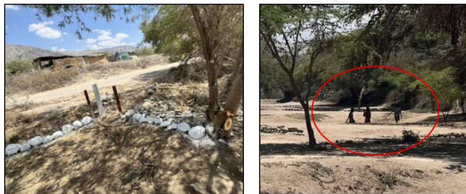
Imágenes N° 51 y 52: Presencia de acceso sin control a los respiraderos
