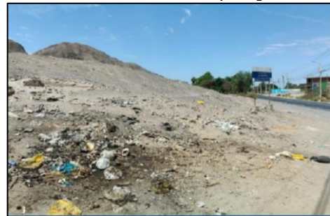
Imagen N° 56: Carencia de cerco perimétrico y acumulación de residuos sólidos aumenta el riesgo de daño a las estructuras arqueológicas
