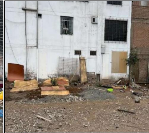
Imagen N° 7: Desmonte y escombros
