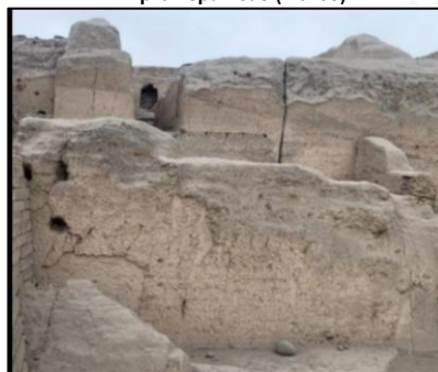
Imagen N° 30: Evidencia de erosión, desprendimiento de enlucidos, fisuras, grietas, hoyos en estructuras arquitectónicas prehispánicas (muros)
